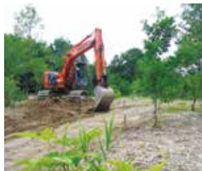
重機によるマウンドの造成
