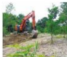
重機によるマウンドの造成
